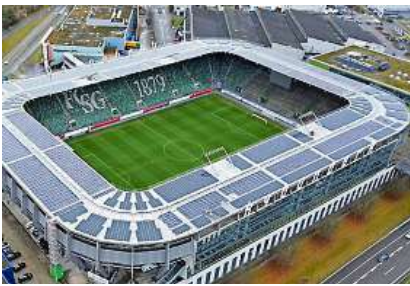
Auf dem Stadionsdach des FC St. Gallen: Die Solaranlage wird ausgebaut. Bild Keystone
